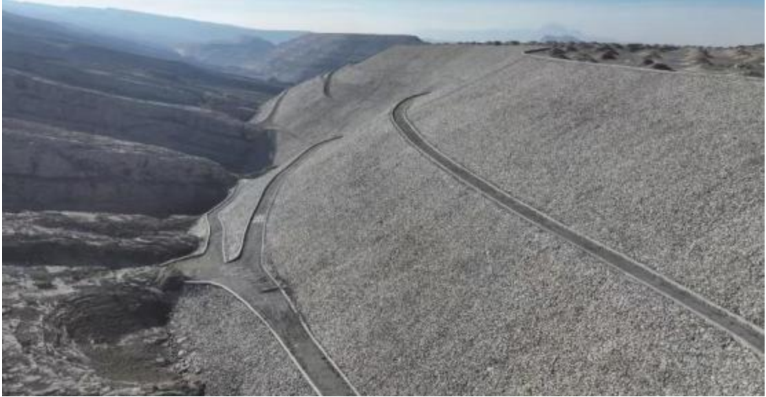
照片 1 排土场东坡面
